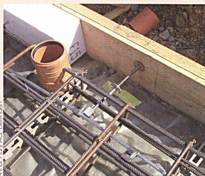
Erdeseil (Stahl 75 mm<sup>2</sup>) mit Fundamenterdungsanschlussgarnitur und korrosionsfester Verlängerung für die Isolation.
