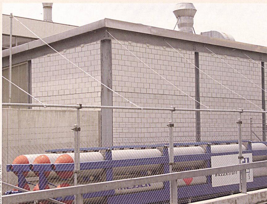
Spezielle Blitzschutzanlage über einem Wasserstofftanklager mit gespannten Fangleitungen.
