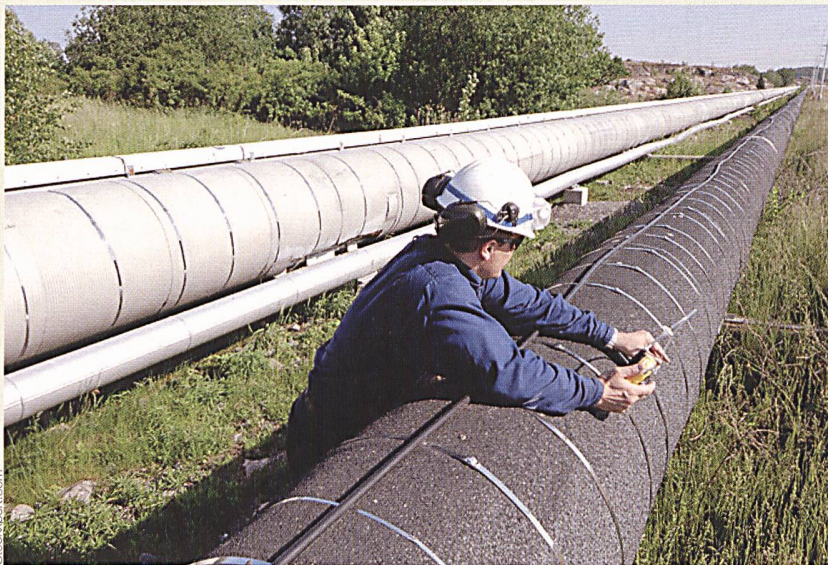
Le réseau suisse de gaz naturel a gagné plus de 200 km.
