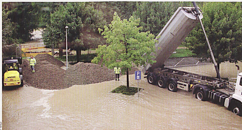
Bau eines Notdamms auf dem EBM-Areal.
