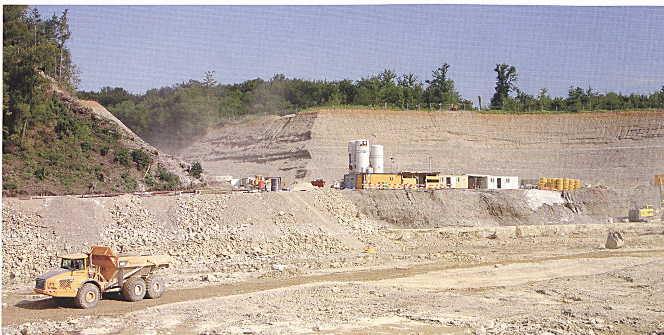
Der Kies zur Aufbereitung des Betons wird direkt am Schweizer Ufer abgebaut.
