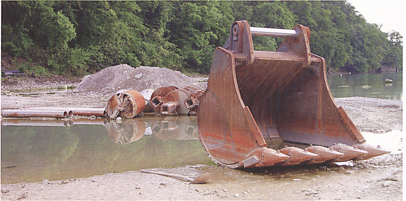
Stillleben auf der Baustelle.
