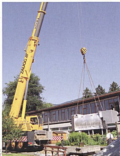
Installation des grössten Schweizer Pelletkessels.
