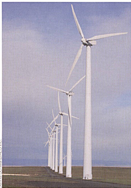
Condon Wind Farm in Condon, Oregon, USA: 43 Turbines des Typs Mitsubishi MWT600 liefern eine Leistung von 49,8 MW.
