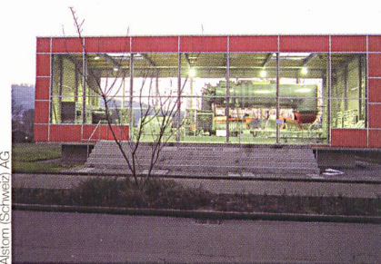
Die 4 MW Leistung der GT Neuenburg dienen ausschliesslich zur Stromproduktion, zuletzt als Notstromgruppe der Stadt Neuenburg.
