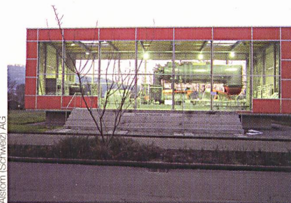
Die 4 MW Leistung der GT Neuenburg dienen ausschliesslich zur Stromproduktion, zuletzt als Notstromgruppe der Stadt Neuenburg.
