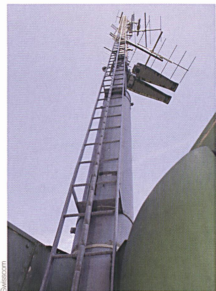
Die Wimax-Basisstation in Boltigen ist vorerst ausgeschaltet. La station de base Wimax à Boltigen est désactivée jusqu'à nouvel ordre.
