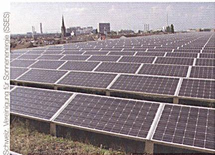
In Deutschland sind bereits rund 3 GW Fotovoltaikleistung installiert; die Schweiz liegt bei rund 30 MW. Im Bild: Fotovoltaikanlage mit 240 kWp auf dem Gründach der Messe Basel (2400 Siemens-SM-110-Panels, 7 Wechselrichter, Jahresertrag 220 000 kWh).
