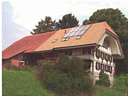
Das Bauernhaus in Bibern bei Bern ist mit 16 m 2 Sonnenkollektoren zur Bereitstellung von Brauchwarmwasser bestückt.
