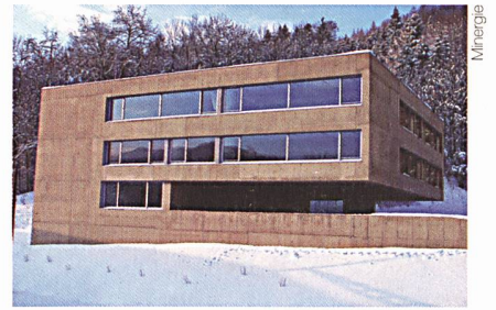
Die Erweiterung der Wirtschaftsschule Baden-Zurzach ist ein gutes Beispiel dafür, dass Architektur mit hohem Anspruch und energiebewusstes Bauen kein Widerspruch sein muss.
