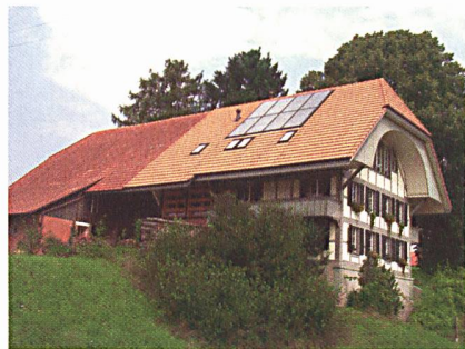
Das Bauernhaus in Bibern bei Bern ist mit 16 m 2 Sonnenkollektoren zur Bereitstellung von Brauchwarmwasser bestückt.
