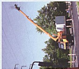
En faisant pivoter la plate-forme élévatrice après exécution de travaux d'entretien sur un éclairage public, la distance de sécurité par rapport à la ligne aérienne n'a pas été respectée ce qui a provoqué un défaut à la terre.
