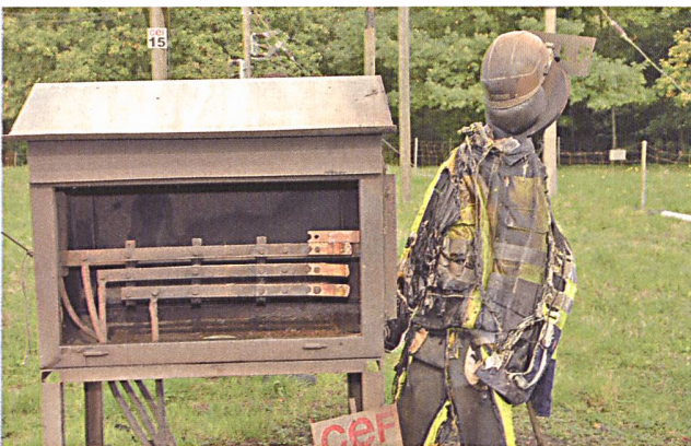
Richtige Arbeitskleidung: Verheerende Folgen nach einem Kurzschluss.
