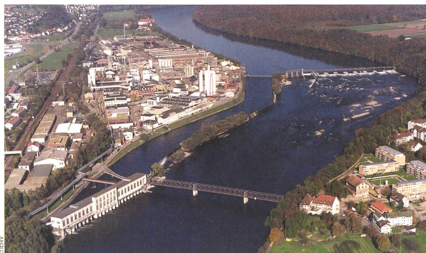
Das alte Kraftwerk Rheinfelden wird durch einen modernen Neubau ersetzt. Die Ausleitung wird verschwinden und der Unterbruch im Fließkontinuum wird durch ein Umgehungsgerinne durchgängig gemacht.
