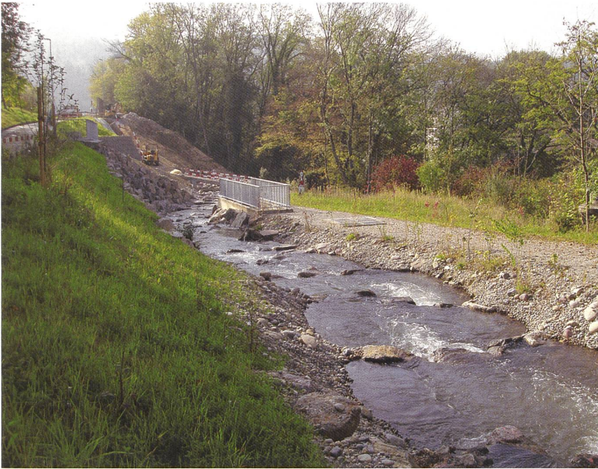
Der neue Fischaufstieg in Wettingen an der Limmat.
