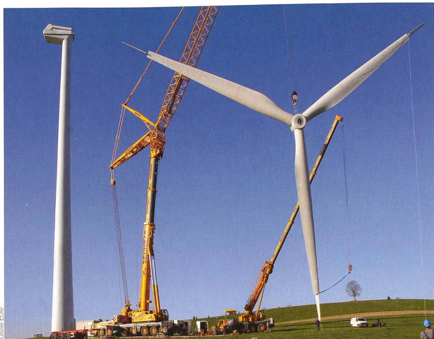
Bei einer Anlage im Entlebuch wird der Rotor angebracht.
