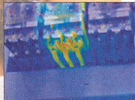
Wärme- und Sichtbild überblendet
