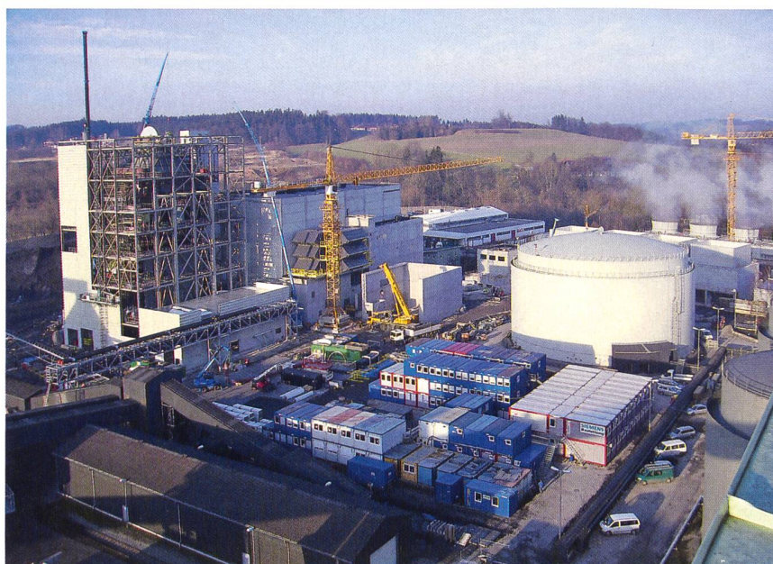
Construction de la centrale à cycle combiné (gaz et vapeur) à Timelkam (Autriche).
