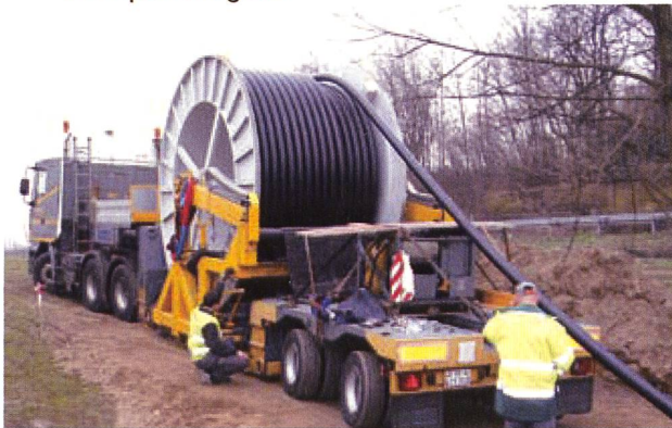
Verlegung des 380-kV-Kabels der grenzüberschreitenden Hochspannungsverbindung zwischen der Schweiz und Italien
