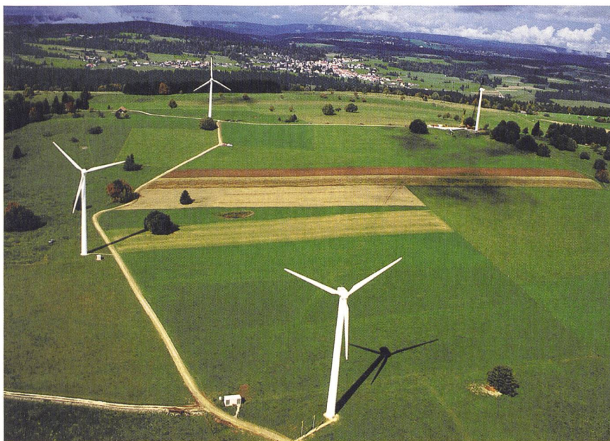
Avec une puissance de près de 4 MW, Mont-Crosin représente actuellement le site éolien le plus important en Suisse.
