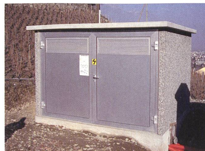
Novelles cabines en béton de Sigmaform. Neue Betonkabinen von Sigmaform.
