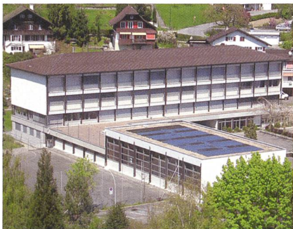
Fotovoltaikanlage mit dem Formsol-Integrationssystem von Zagsolar auf dem Turnhallendach Amlehn in Kriens.
