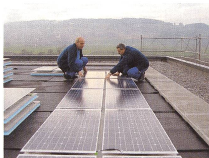
Montage von Solaranlagen durch Spezialisten der Zimmermann-Technik AG.
