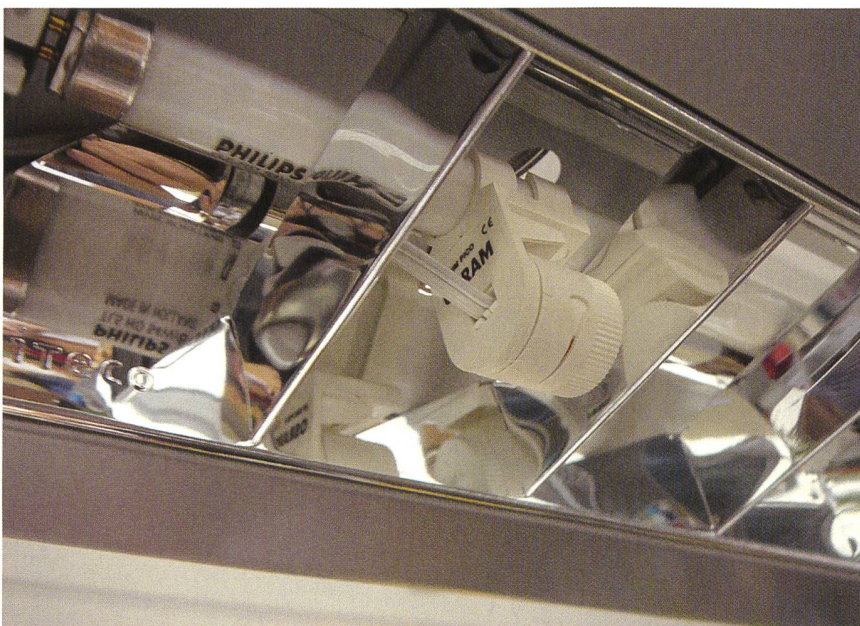
Bild 10 Die Helligkeitssensoren sind direkt in die Leuchten eingebaut: Kein Bereitschaftsverbrauch mehr, sobald das Licht ausgeschaltet wird!
