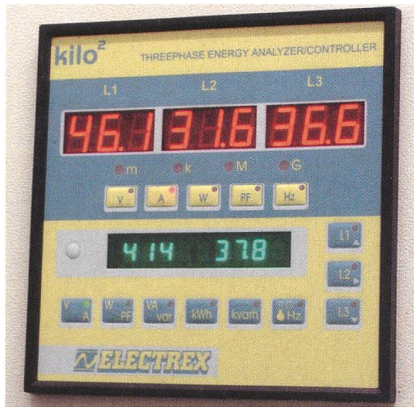
Bild 11 Leider ist die symmetrische Aufteilung der einphasigen Lasten nicht optimal gelungen.
