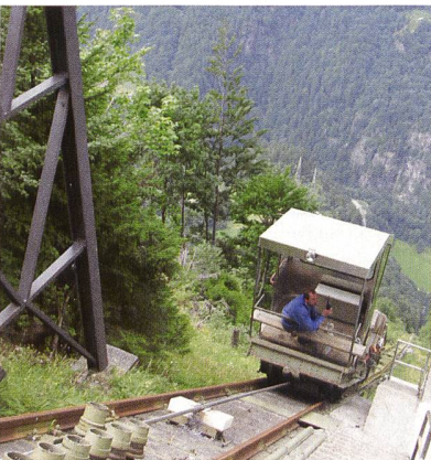
Bild 3 Standseilbahn als Zufahrt zum Wasserschloss.
