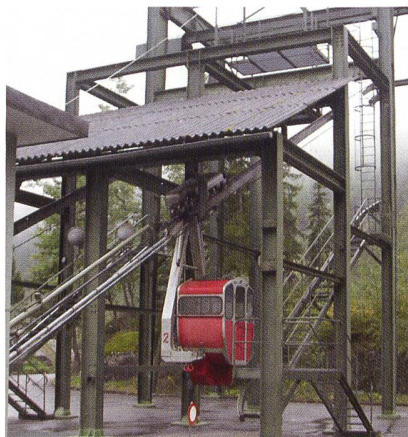
Bild 4 Seilbahn als Zufahrt zu einer Staumauer.
