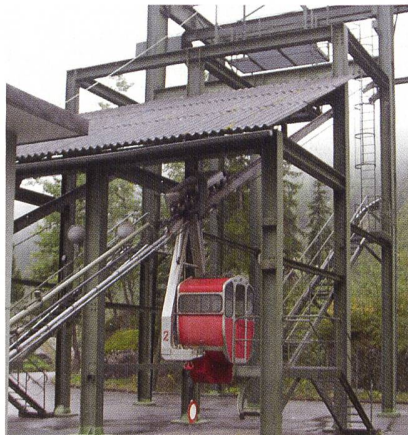
Bild 4 Seilbahn als Zufahrt zu einer Staumauer.
