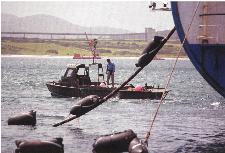
Bild 4 Verlegung des Hochspannungsgleichstromkabels im Mittelmeer.
