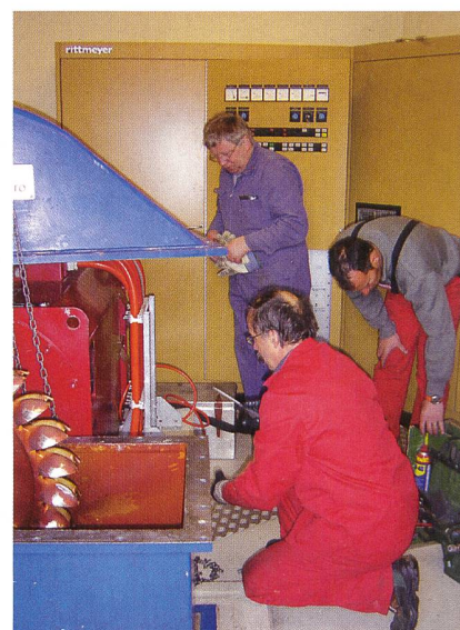
Revisionsarbeiten an der Trinkwasserturbine Gärsterna in Ried-Brig / Termen.
