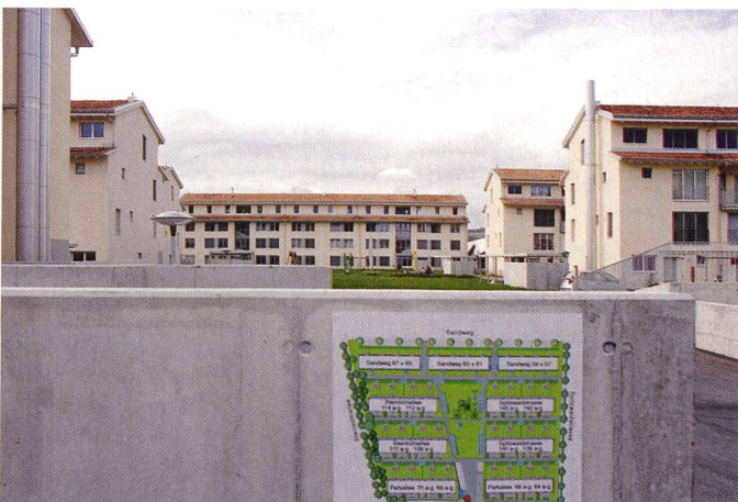
Allschwil: Blockheizkraftwerk Überbauung Bettenacker.
