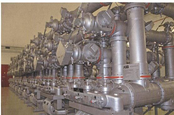
An der gasisolierten 150-kV-Schaltanlage des Unterwerks Zeughaus in Zürich wurden bei der Diagnose 90 Messungen durchgeführt.
