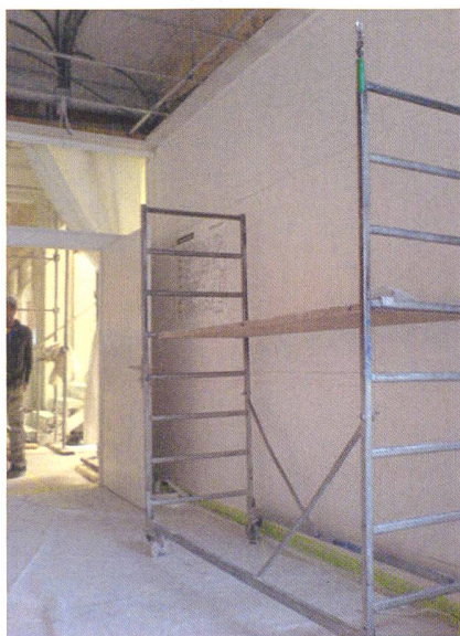
Bild 1 Die Deckenprofile, an denen der Monteur auf dem Rollgerüst arbeitete, standen unter Spannung.
