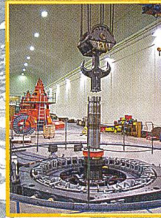
Kraftwerk-Retrofit und Neubau
