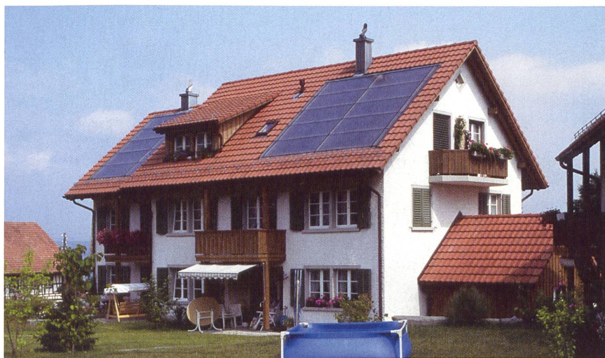
Mit Sonnenkollektoren auf dem Dach zum Klimaschutz beitragen: Wird die elektrische Ergänzungsenergie für den Solar-Elektroboiler als Ökostrom aus Wasserkraft, Biomasse oder Fotovoltaik bezogen, ist die ökologische Warmwasserversorgung perfekt.
