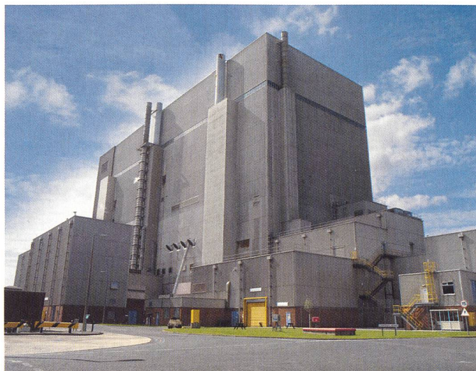
British Energy betreibt die britischen KKW und ist der wichtigste Stromproduzent des Landes.
