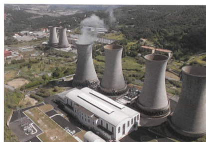
Ab 2010 wird an der Universität Neuenburg Kontinentaleuropas erster Geothermielehrgang angeboten. Im Bild: Geothermisches Kraftwerk der Enel.
