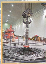
Kraftwerk-Retrofit und Neubau
