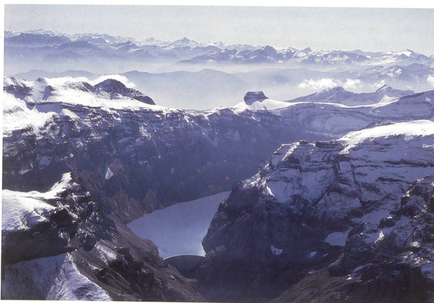
Bild 1 Limmernsee ob Tierfehd und Blick auf die Alpen: Die neuen Kraftwerksanlagen kommen grösstenteils unterirdisch zu liegen.
