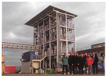
Das Entwicklerteam des PSI und der TU Wien vor der Testanlage zur Erzeugung von Methan aus Holz im österreichischen Güssing.
