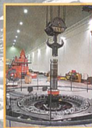
Kraftwerk-Retrofit und Neubau
