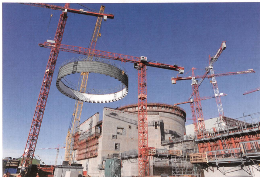
Bild 1 Einsatz eines Elements der inneren Sicherheitshülle auf der EPR-Baustelle in Olkiluoto, Finnland, März 2009.
