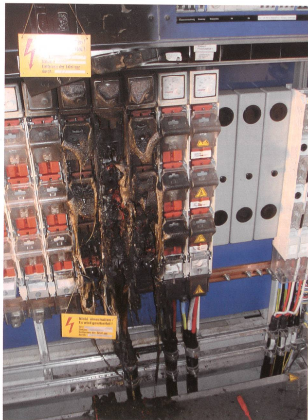
Bild 1 Abgebrannter NHS-Anschluss.
