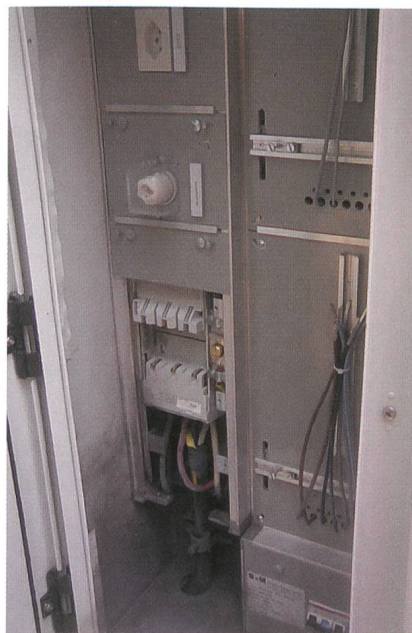
Bild 5 Hier sollte nun noch die Abdeckung montiert und anschliessend plombiert werden.
