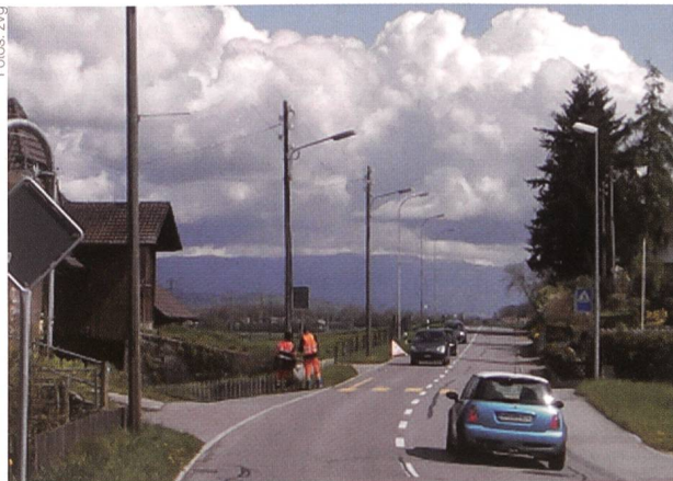
Team bei der Kontrolle an der Freileitung.
