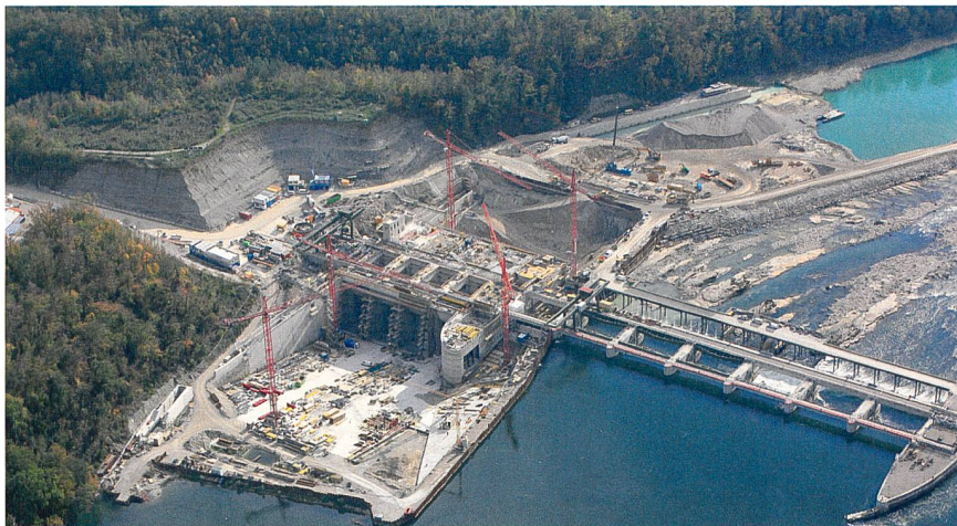
Kraftwerk Neu-Rheinfelden, Bau des Maschinenhauses, Oktober 2009.
