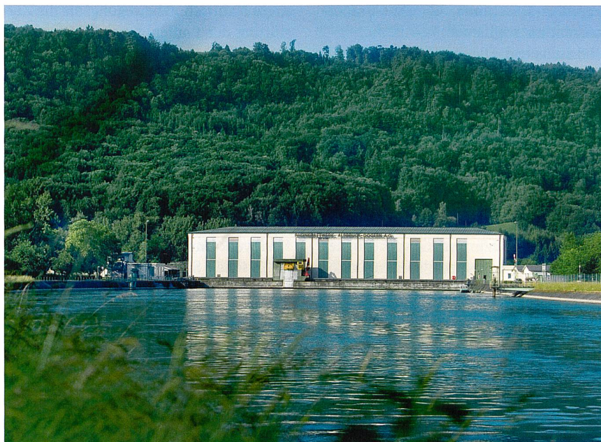
Rheinkraftwerk Albruck-Dogern, Maschinenhaus.
