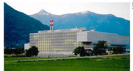
Die kantonale Verbrennungsanlage ICTR in Giubiasco wird durch ACR betrieben.
