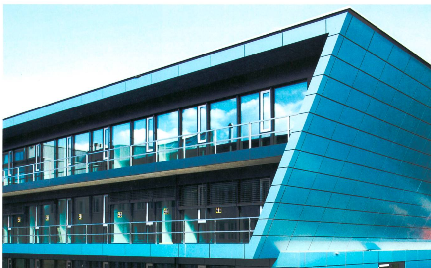
Fassade der Südseite: Durch die grosse Fensterfront wärmt die Sonne, im Sommer spenden die Balkone Schatten.
