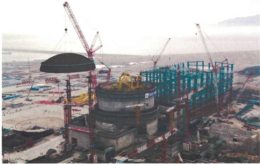
Montage der Reaktorkuppel von Taishan-1 (China): Mit einem Umfang von 147 m und einem Gewicht von 270 t gemäss Bauunternehmen die Grösste der Welt.
