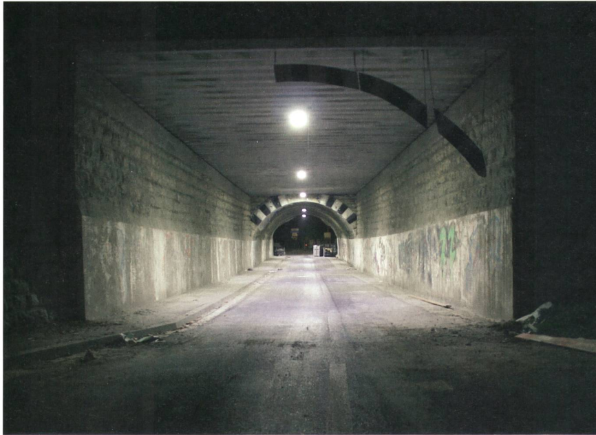
Bild 5 Eine Unterführung wurde durch EWB mit 5 LED-Leuchten à 70 W Systemleistung ausgerüstet. Die Ausleuchtung ist hervorragend.
