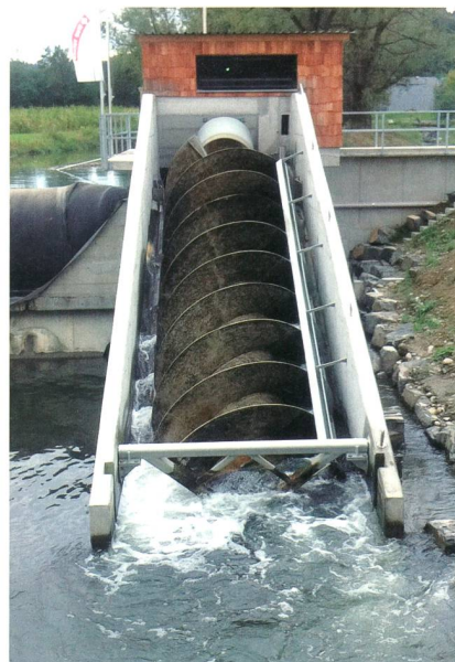
Mit einer Nennleistung von 100 kW liefert die Schraube Strom für rund 100 Haushalte.
