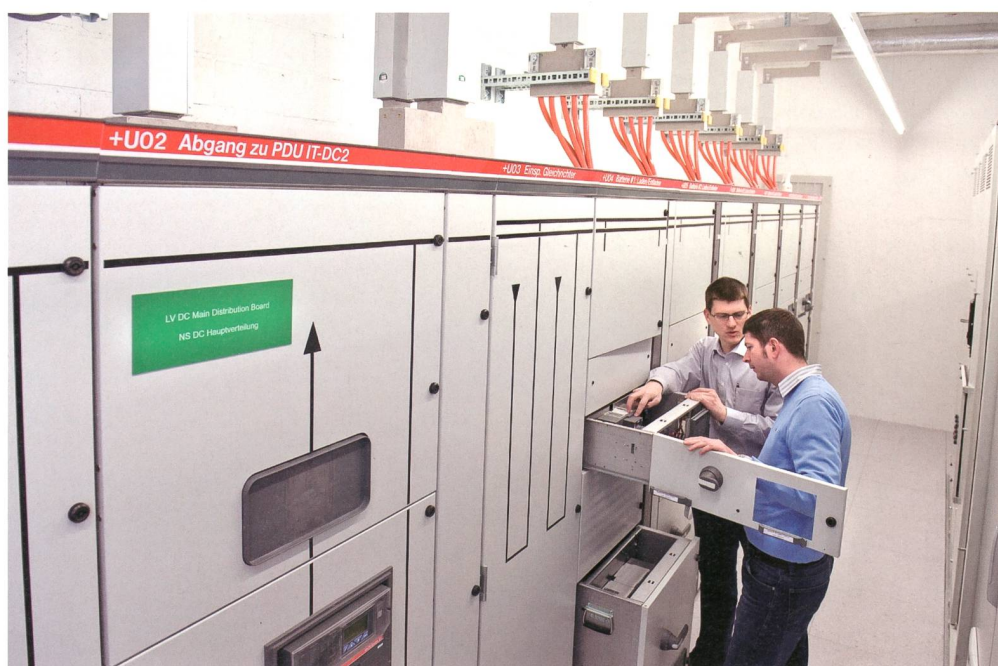
Bild 1 ABB-Mitarbeiter der Geschäftseinheit Niederspannungssysteme im Gleichstrom-Versorgungstrakt im Rechenzentrum der Green Datacenter AG.
