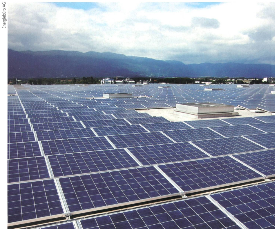
Bild 1 Blick auf Dachfläche in Genf.
