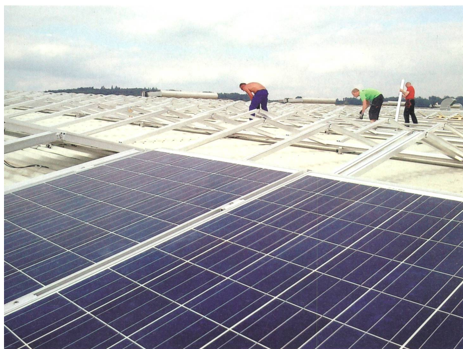
Bild 7 Modulmontage der 25 000 m 2 grossen Anlage auf der Industriehalle der Ferrowohlen AG.
