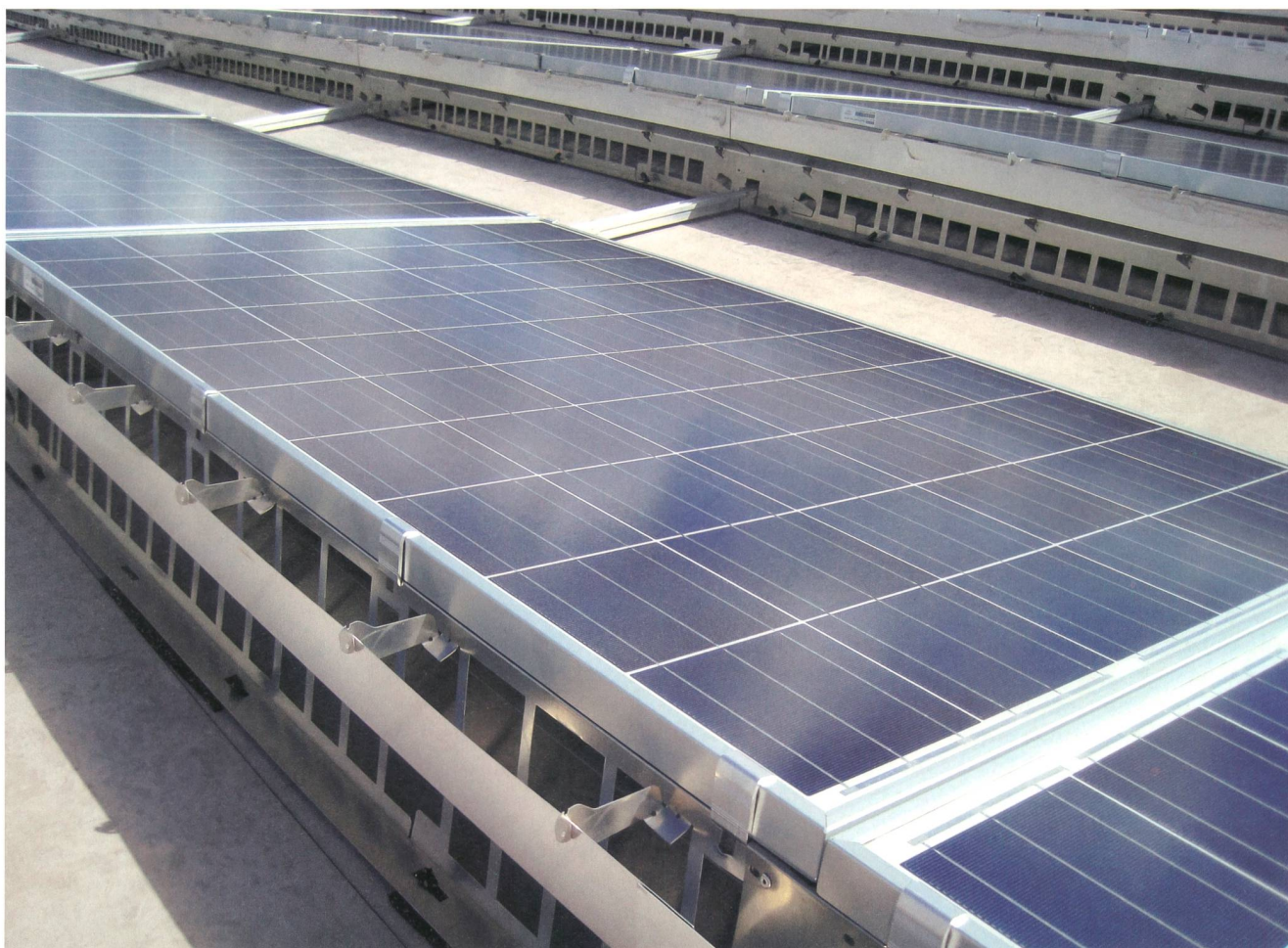
Bild 3 Leichtbauunterkonstruktion mit Spoiler am Heck des Aufständersystems.
