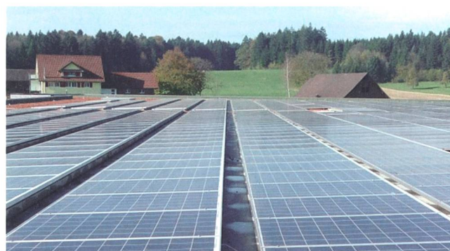
Bild 4 Teilansicht auf das Flachdach der Solaranlage Pistor-Edison Power.
