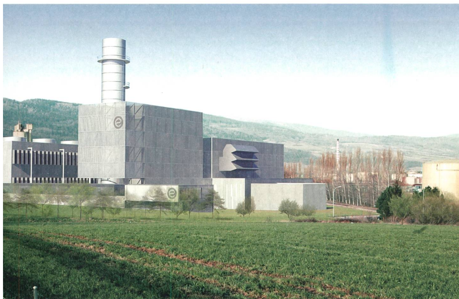
Le site de Cornaux dispose de nombreux atouts pour accueillir la nouvelle centrale à gaz.
