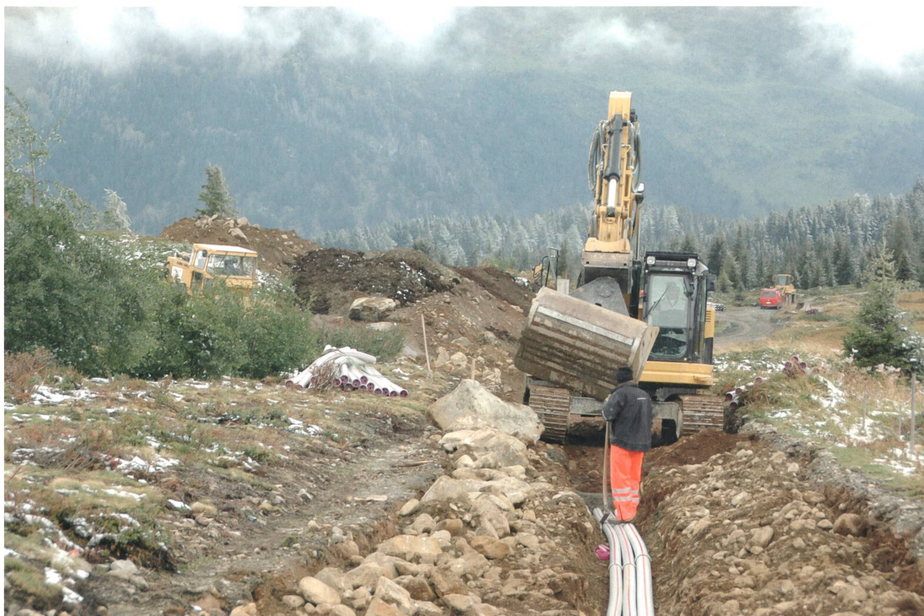
Bild 3 Die Verkabelung ist zwar teuer, wertet aber das Landschaftsbild auf und liefert die Elektrizität mit einer höheren Ausfallsicherheit.
