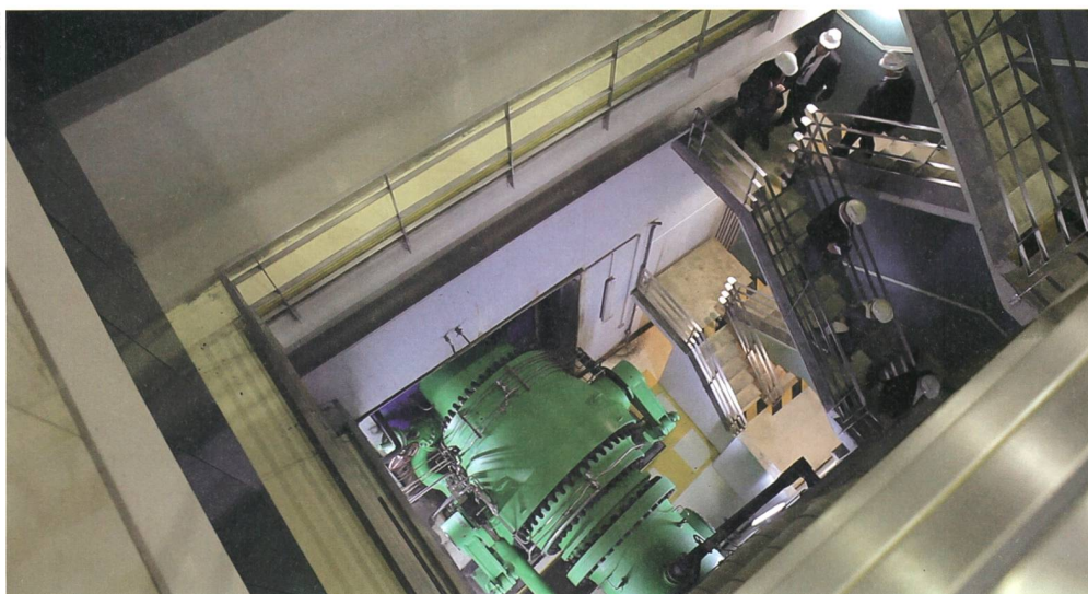
Bild 3 Schieber des Venda-Nova-II-Pumpspeicherkraftwerks (Anschlussleistung 200 MW). Venda Nova III wird zurzeit gebaut und soll mit 2 x 380 MW Ende 2015 ans Netz gehen. Dieses mit drehzahlvariablen Francisturbinen ausgestattete Pumpspeicherkraftwerk ist eines der weltweit grössten.
