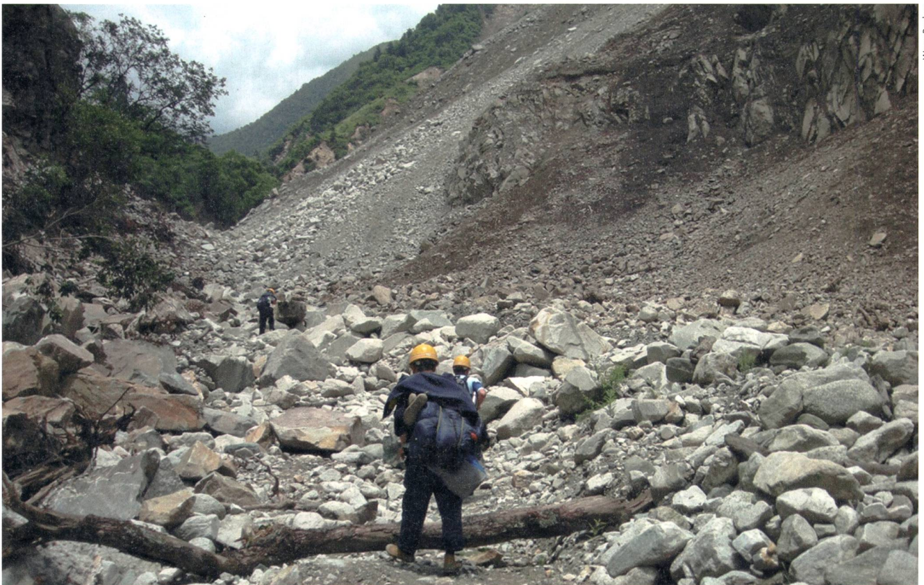
Bild 8 Zugeschüttete Verbindungsstrasse zur Shapai-Bogenmauer (Wenchuan-Erdbeben 2008, Sichuan, China).
