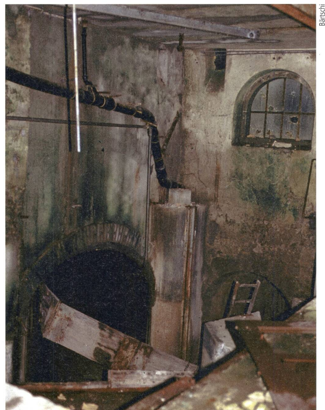
Bild 6 Innenansicht des 1859–1863 erbauten Wasserschlosses für das Pumpspeicherwerk Schmid Gattikon vor dem Abbruch (Aufnahme vom 13. März 1983).
