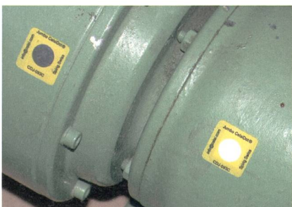
Thermoetiketten zeigen mögliche Probleme auch aus grösserer Distanz frühzeitig an.
