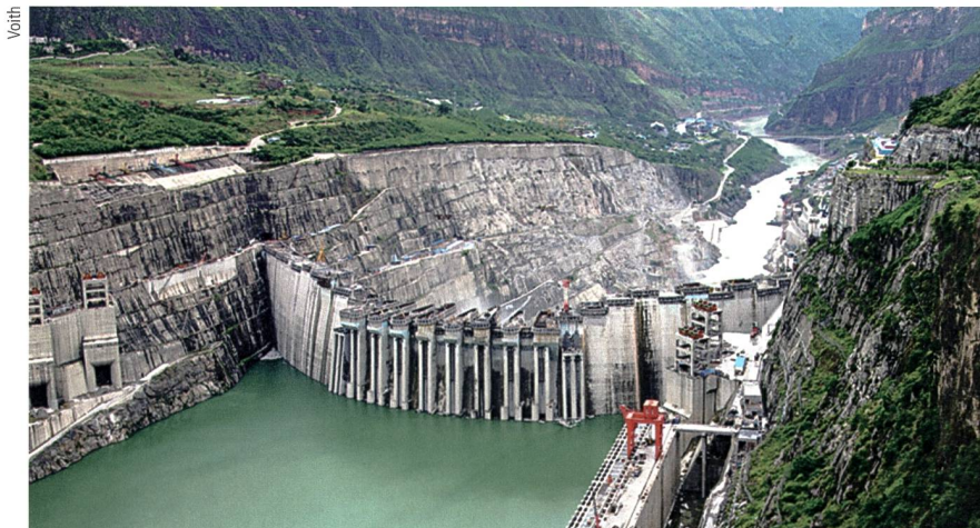
Wenn das Kraftwerk Xiluodu im Juni 2014 komplett ans Netz geht, wird es mit seinen insgesamt 18 Maschineneinheiten eine Nennleistung von 13,86 GW haben.
