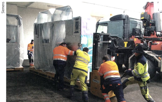
Bild 4 Anlieferung der Schaltfelder.
