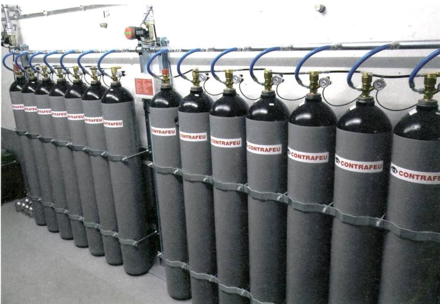
Stickstoffflaschenbatterie für zwei Löschbereiche mit mechanischer Blockiervorrichtung.
