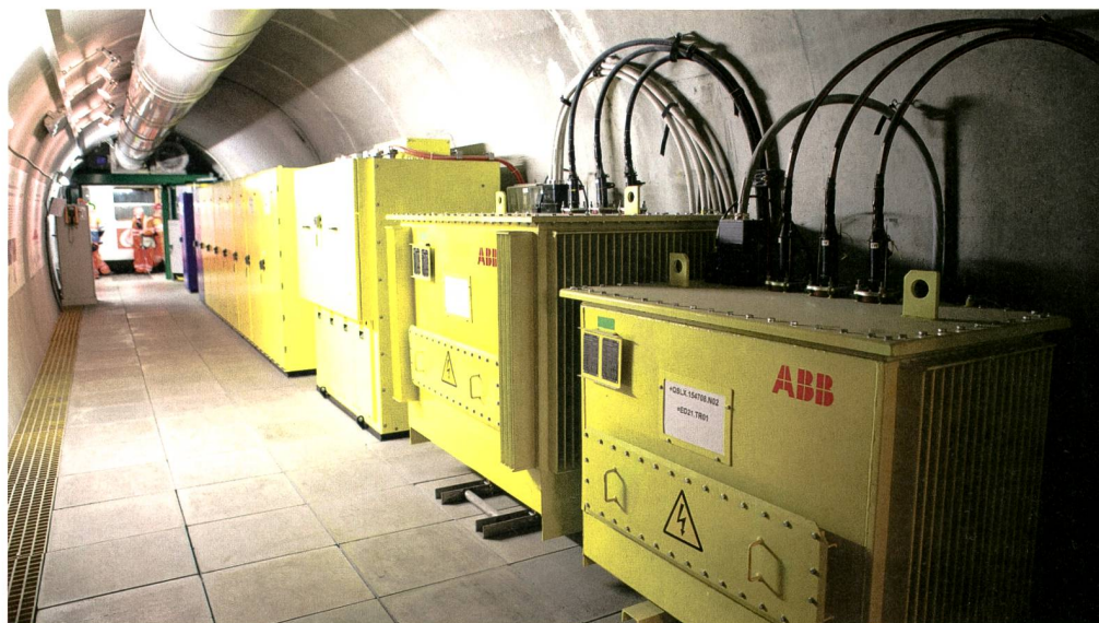
Die Querschläge zwischen West- und Oströhre dienen einerseits als Fluchtwege und andererseits als Installationsorte für die Tunnelbetriebs-Ausrüstung (Stromversorgung, Kommunikation, Lüftung ...).
