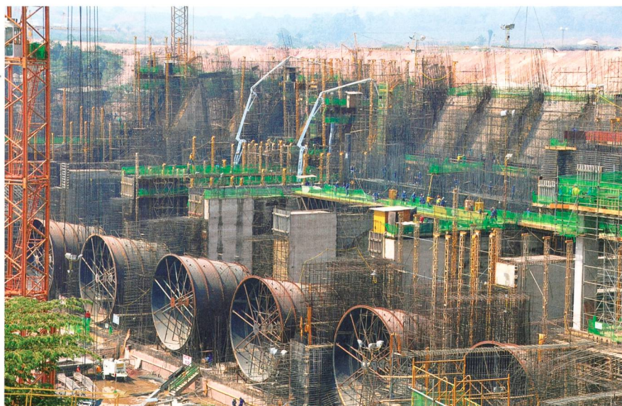
Figure 4 Mise en place de l'armature des aspirateurs de la centrale rive droite en cours de construction, 30 août 2012.
