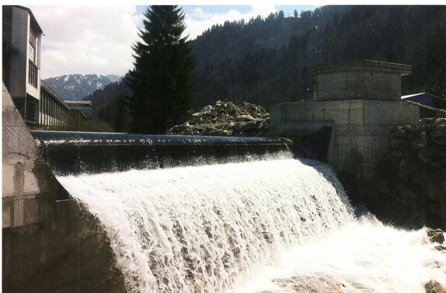
**Figure 5** Seuil réhabilité sur la Tzintre, dans le canton de Fribourg, lors de la fusion de deux centrales (débit : 5 m<sup>3</sup>/s, chute : 11 m, puissance électrique : 450 kW, mise en service en 2013).
