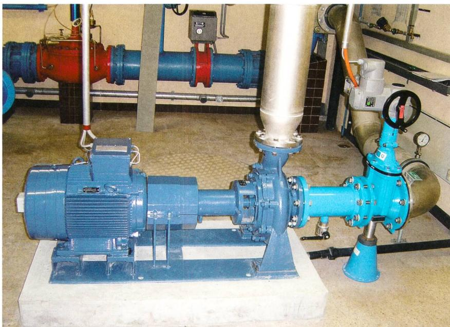
**Figure 2** Pompe inversée sur l'eau potable de la ville de Morges (débit : 76 l/s, chute : 43 m, puissance électrique : 23 kW, production électrique : 125 000 kWh/an, mise en service en 2011).
